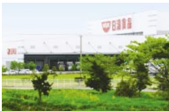
静岡県大井川町にある日清食品静岡工場
