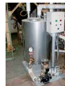
ドライヤー室ドレン回収装置
